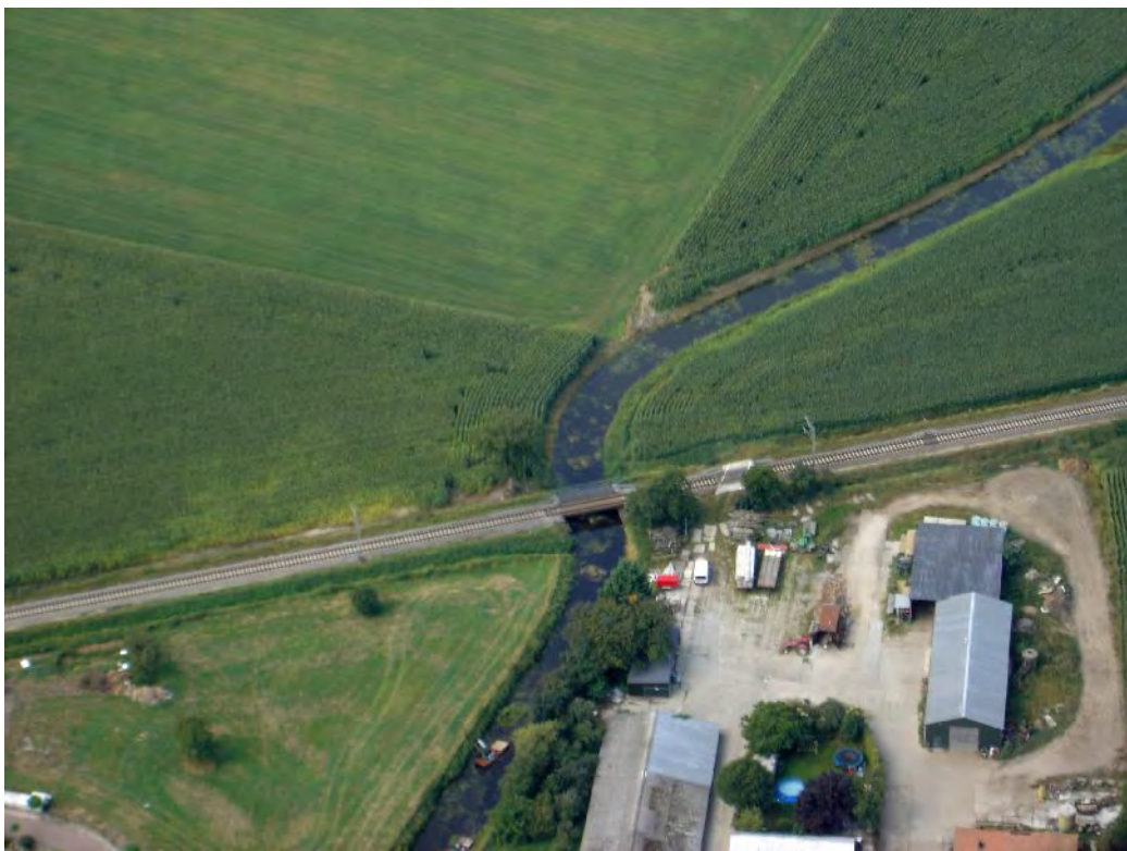
C – Tussen C en D Spoor over Barneveldse Beek Zuid-oost van Barneveld
